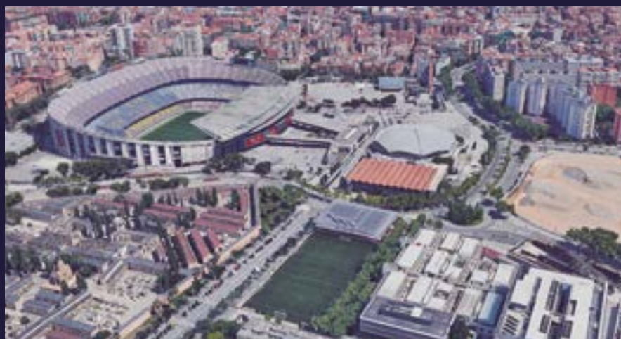
SITUACIÓN ACTUAL Las instalaciones del Club en Les Corts hoy en día, tras el derribo del Miniestadi
