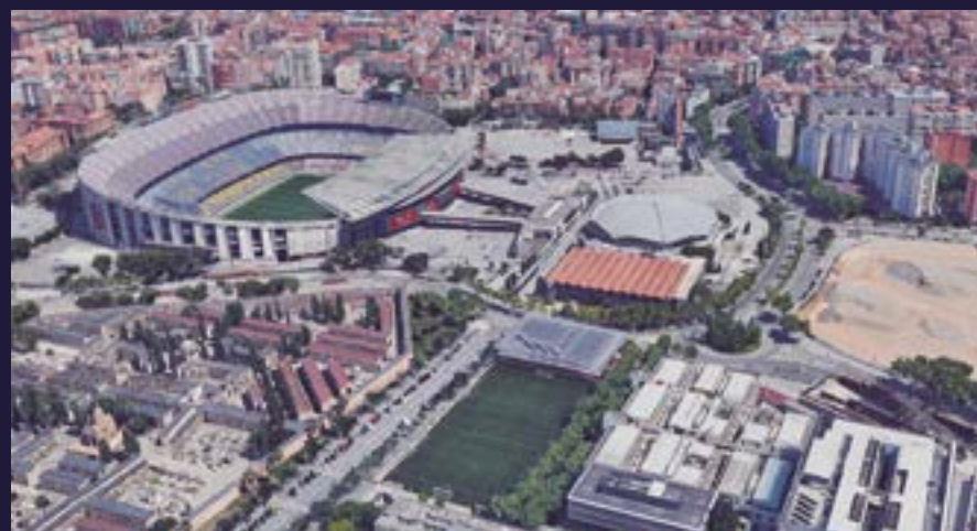
SITUACIÓ ACTUAL Les instal·lacions del Club a les Corts avui en dia, després de l'enderroc del Miniestadi
