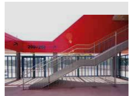
Escalas d'accés a la segona graderia de Tribuna.
